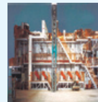
2階建AL鋳物T6 熱処理炉
