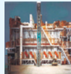
2階建AL鋳物T6 熱処理炉
