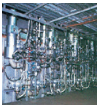
連続焼鈍設備用HRSRT バーナ
