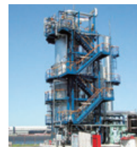
廃液・廃ガス燃焼装置
