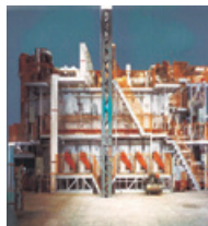
2階建AL鋳物T6 熱処理炉
