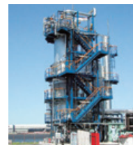
廃液 & 廃ガス燃焼装置
