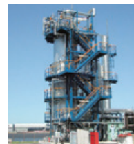
廃液 & 廃ガス燃焼装置
