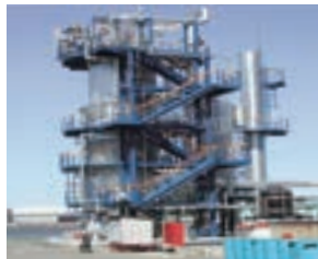
廃液 & 廃ガス燃焼装置
