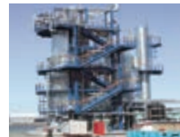
廃液・廃ガス燃焼装置
